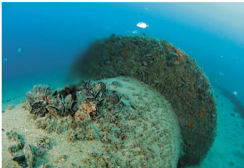
Figura 65. Tramo difusor del emisario de salmueras de la desaladora de Blanes (Girona). Por cortesía de Ecoproges S.L. Fotografos: Joan Carles Fluxà y Jordi Chías
