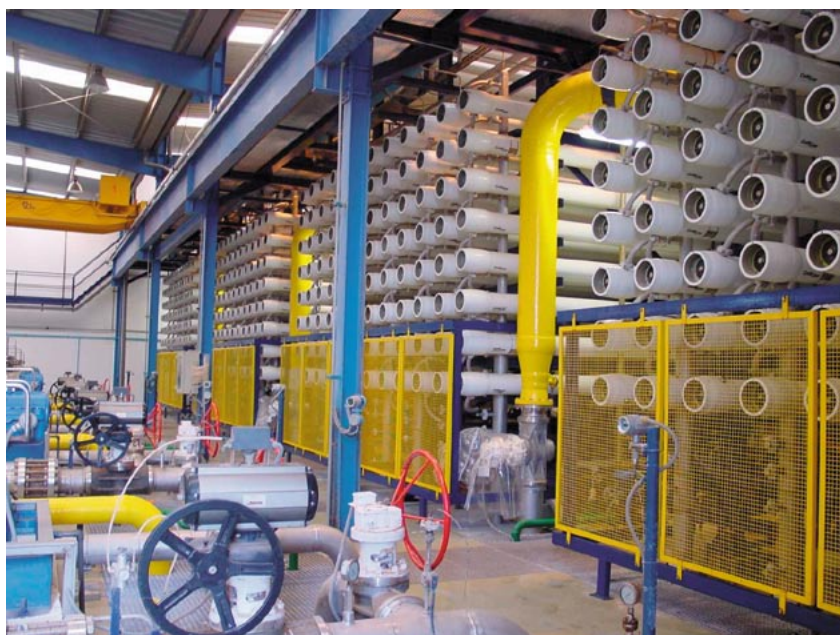
Figura 16. Aspecto general del interior de una desaladora de osmosis inversa. Imagen cortesía de INALSA
