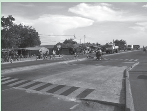
Las dos áreas elevadas están distribuidas escalonadamente en ambos extremos de la isla central, para desacelerar los vehículos antes de las sendas peatonales.
