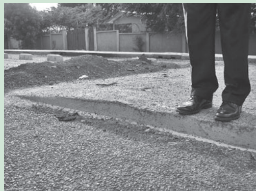
Ilustración de la sección transversal de un área elevada de concreto, rampas de 10 cm de alto y 1 m de largo para la velocidad deseada (30 km/h).
